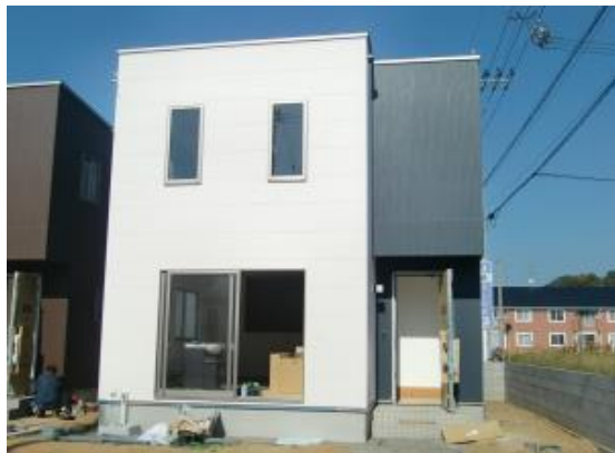
A棟・C棟・E棟
